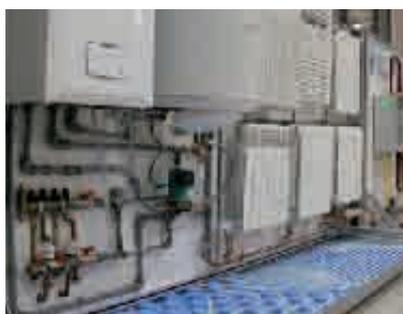
Detalles de montaje de emisores térmicos y suelo radiante en instalación de calefacción por gas.
