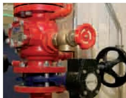
Válvula de control de flujo en el simulador de instalación de protección contra incendios.
